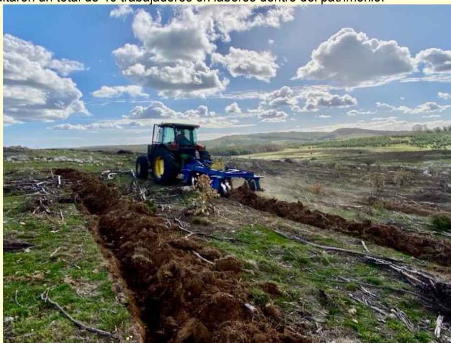
Actividades de preparaciones de suelo para reforestación
